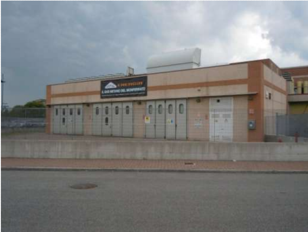
Centrale di cogenerazione a gas al servizio di una rete di teleriscaldamento
